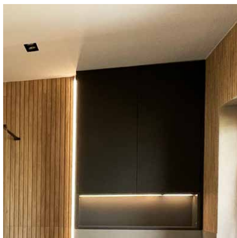
Klasyczna szafka nad geberitem urozmaicona o wnękę z oświetleniem ledowym. Mebel ten dodatkowo maskuje wszystkie przewody elektryczne wykorzystane do zasilania pozostałego oświetlenia łazienki.
